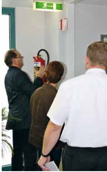
Abb. 3: Sind die Rettungs- und Fluchtwege frei begehbar oder behindern Gegenstände den Durchgang? Dieser Feuerlöscher hängt in einer Nische deutlich sichtbar neben dem ausgeschilderten Fluchtweg
